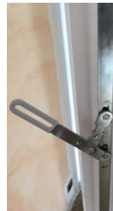
Verrou toute hauteur Pour déverrouillage semi-fixe oscillo-battant
